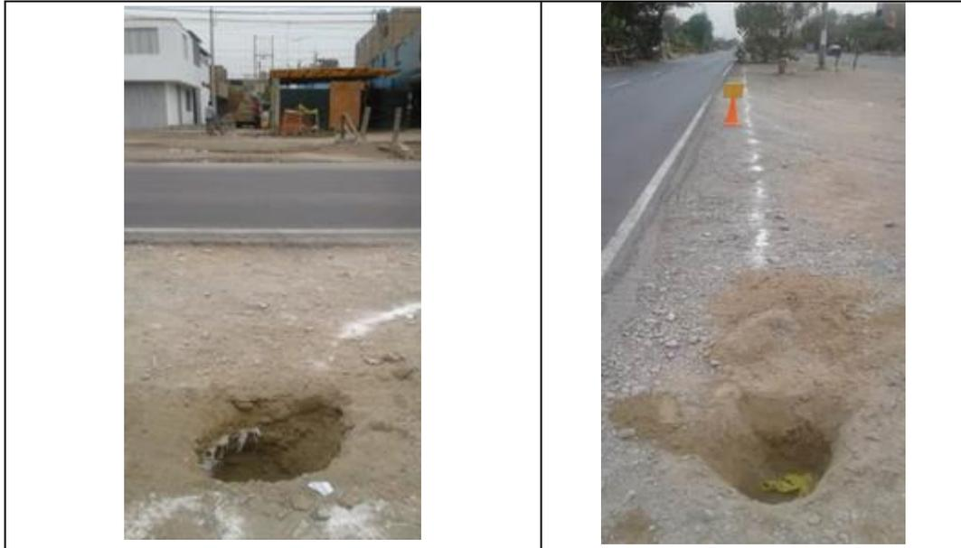
Se confirma que la tubería existe y corresponde al servicio de gas natural administrado por Calidda. Es transversal al eje del proyecto como se puede observar en la siguiente vista:
